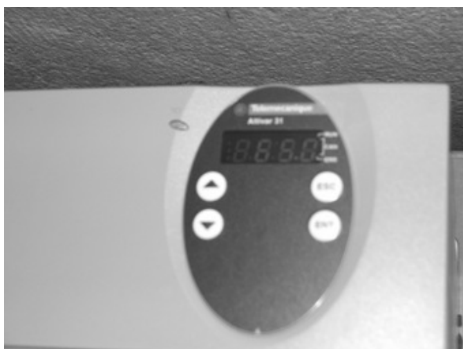
ภาพประกอบที่ 3.5 การปรับความถี่ของ Inverter
