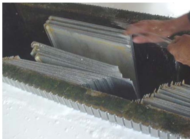
ภาพที่ 20 คราบสกปรกสีเหลืองที่แผ่นเลียบ
