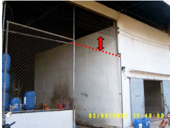
ภาพที่ 35 การตัดคานประตูเพื่อให้สามารถเข็นรถตากยางออกนอกโรงรมได้
