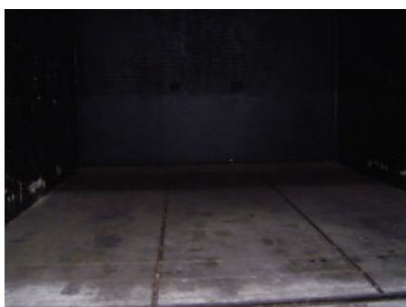
ภาพประกอบที่ 2.5 ลักษณะผนังห้องที่ทำด้วยสี Bituminous
