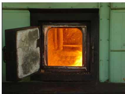
ภาพประกอบที่ 4.32 ห้องเผาไหม้เชื้อเพลิงของหม้อต้มน้ำ
