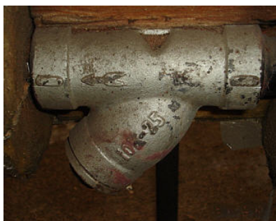
ภาพประกอบที่ 4.35 ลักษณะของตัวดักสิ่งสกปรก
