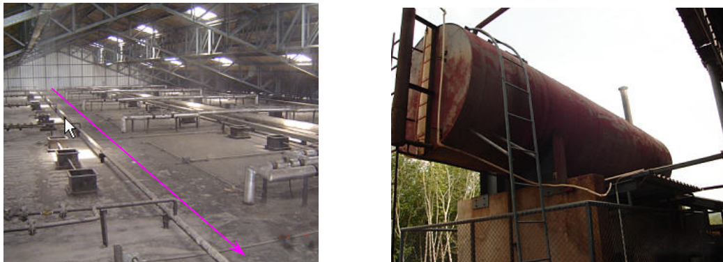
ภาพประกอบที่ 4.40 ท่อนำน้ำกลับสู่ถังคอนเดนเซอร์
