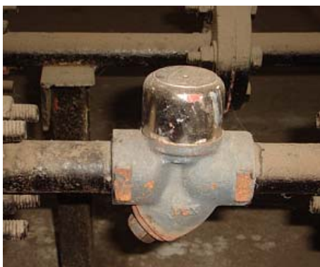
ภาพประกอบที่ 4.39 อุปกรณ์กับดักไอน้ำ
