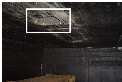
ภาพประกอบที่ 4.44 ช่องระบายความชื้น จากข้างในเตาอบส่วนบน
