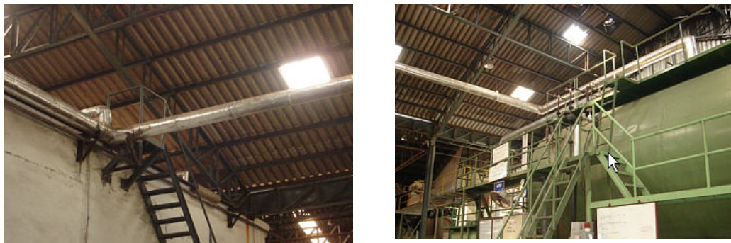
ภาพประกอบที่ 4.33 ท่อลำเลียงไอน้ำจากหม้อต้มน้ำไปยังห้องอบ
