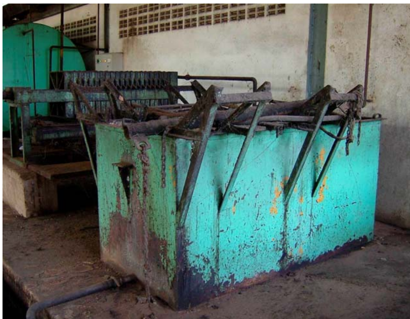
ภาพประกอบ 22 ระบบเก็บไขน้ำมันเสียบโรงงานทักษิณอุตสาหกรรมน้ำมันปาล์ม
