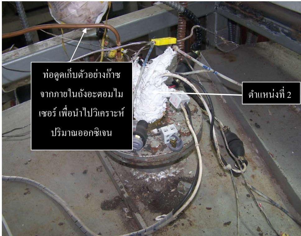
รูปที่ 3.9 ตำแหน่งที่ 2 จุดเก็บตัวอย่างก๊าซจากภายในถังอะตอมไมเซอร์
