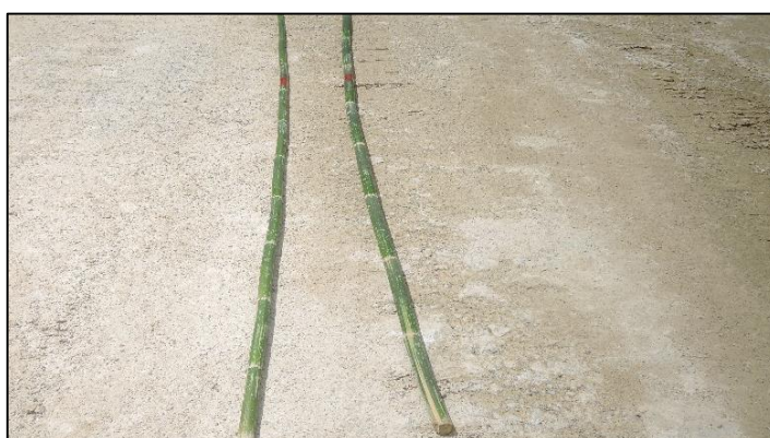
รูปที่ 3.24 ไม้สำหรับการอัดระเบิด
