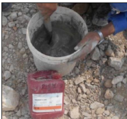
รูปที่ 2.19 Stemming Plug ครั้งที่ 3 ปูนมอร์ต้า (Cement Plug) (Ur Rehmen et al., 2021)
