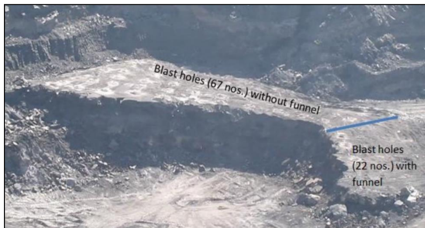
รูปที่ 2.24 แสดงรูปแบบการระเบิด ที่เหมืองถ่านหินที่โบกาโรตะวันตก (Bhaskar et al., 2019)
