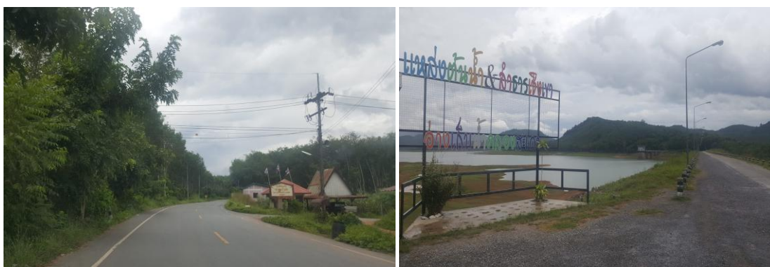
รูปภาพที่ 4.9 (ซ้าย) ถนนทางเข้าอ่างเก็บน้ำคลองสะเดา และ (ขวา) ถนนบริเวณอ่างเก็บน้ำคลองสะเดา ตำบลสำนักแต้ว
