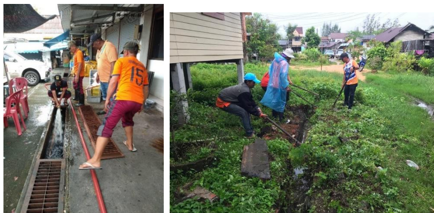
ภาพประกอบ 21 โครงการทำความสะอาดและขุดลอกคูระบายน้ำ
