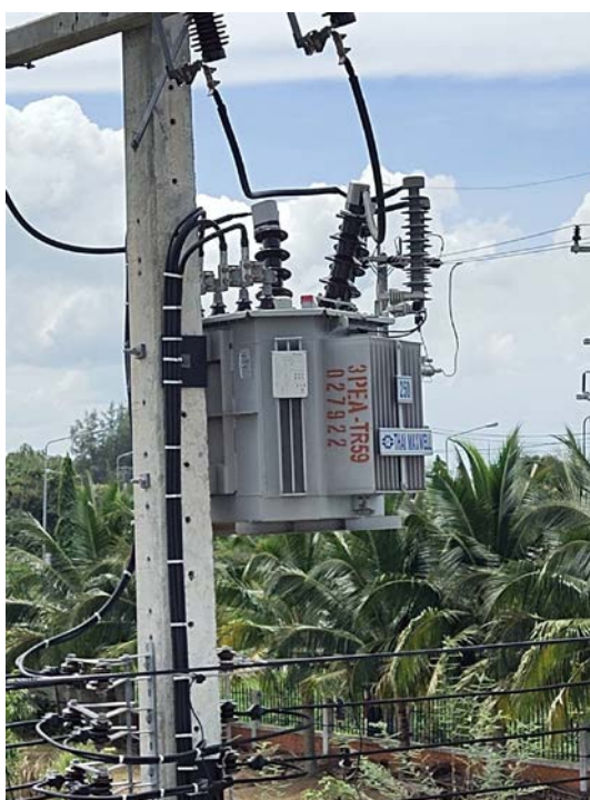
ภาพประกอบ 3-1 การติดตั้งหม้อแปลงไฟฟ้าระบบจำหน่าย 33 kV
