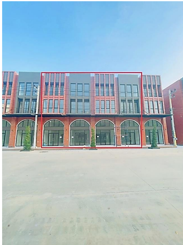
ภาพที่ 1.5 อาคารพาณิชย์ในโครงการศิรินคร สแควร์
