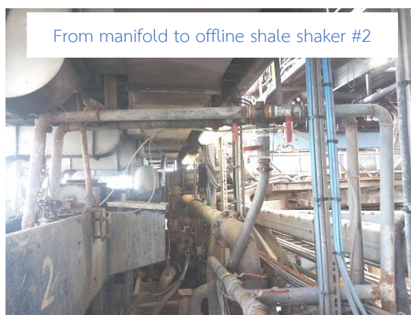
ภาพที่ 4.15 การติดตั้งท่อขนาด 2 นิ้ว บริเวณชุดตะแกรงร่อน
