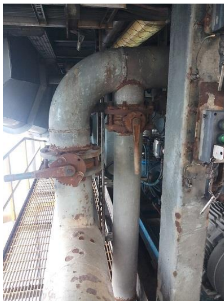
ภาพที่ 4.15 การติดตั้งท่อขนาด 2 นิ้ว บริเวณชุดตะแกรงร่อน (ต่อ)
