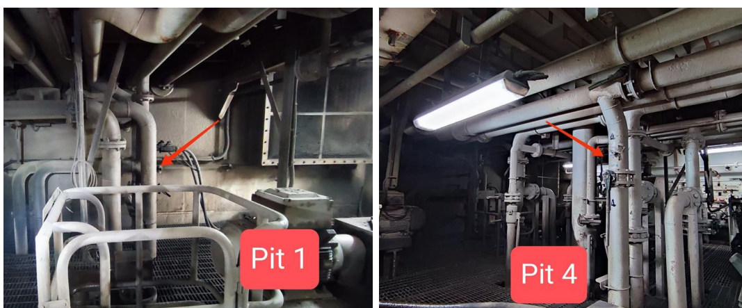
ภาพที่ 4.16 การติดตั้งท่อแยกขนาด 6 นิ้ว และบ่อแยกรับน้ำโคลนแต่ละหมายเลข
