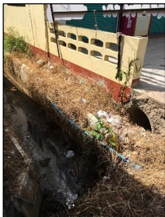
ภาพประกอบที่ 43 : มาตราเชิงโครงสร้าง การขุดลอกคูระบายน้ำในพื้นที่หมู่ที่ 4 บ้านบาตูปูเต๊ะ และหมู่ที่ 5 บ้านหลังเขา เพื่อลดผลกระทบจากน้ำป่าไหลหลาก
