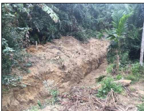
ภาพประกอบที่ 35 : การขุดคลองระบายน้ำในพื้นที่ต้นน้ำ หมู่ที่ 5 บ้านหลังเขา ถ่ายภาพโดยผู้วิจัย (2563)
