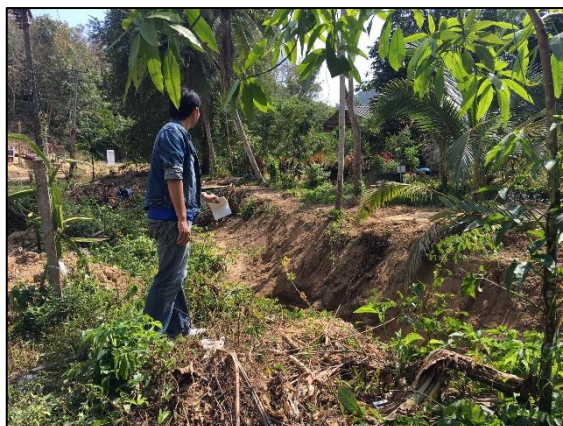
ภาพประกอบที่ 43 : มาตราเชิงโครงสร้าง การขุดลอกคูระบายน้ำในพื้นที่หมู่ที่ 4 บ้านบาตูปูเต๊ะ และหมู่ที่ 5 บ้านหลังเขา เพื่อลดผลกระทบจากน้ำป่าไหลหลาก
