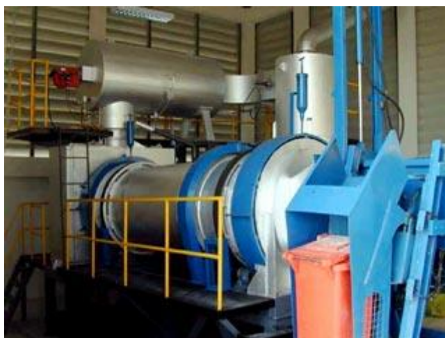
ภาพที่ 2-2 เตาเผาขยะมูลฝอยแบบหมุน
