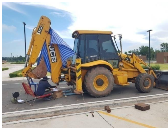
รูปที่ ซ.3 ทดสอบ Plate Bearing บนผิวทางแอสฟัลต์คอนกรีตผสมน้ำยาง 5%
