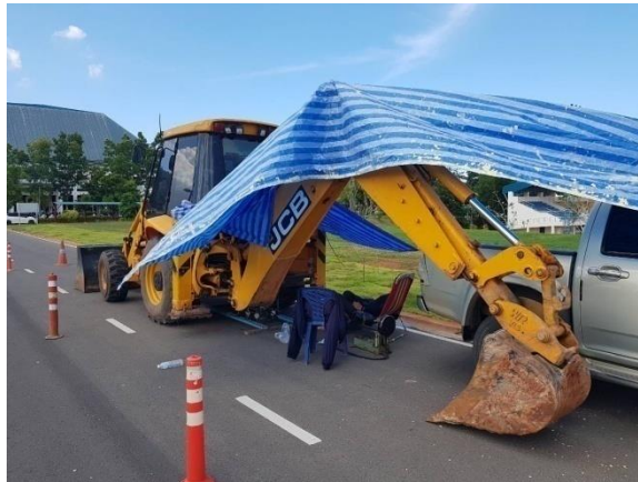
รูปที่ ซ.5 ติดตั้งอุปกรณ์ทดสอบ
