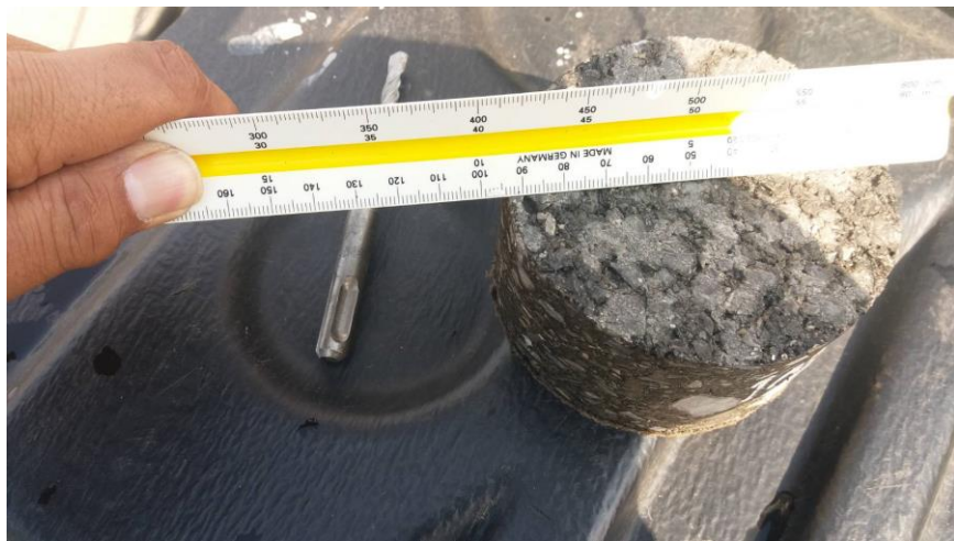
รูปที่ ๒ ทดสอบ Coring ผิวทางแอสฟัลต์คอนกรีตที่ผสมน้ำยางพารา 10%
