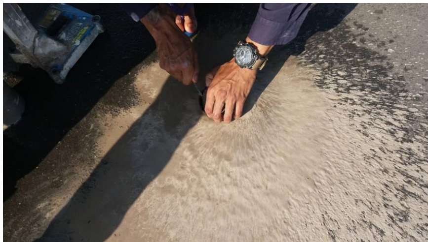
รูปที่ ๑.๑ ทดสอบ Coring ผิวทางแอสฟัลต์คอนกรีตที่ผสมน้ำยางพารา 5%
