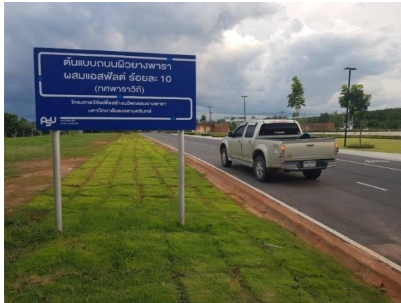
รูปที่ ซ.4 ผิวทางแอสฟัลต์คอนกรีตที่ผสมน้ำยางพารา 10%
