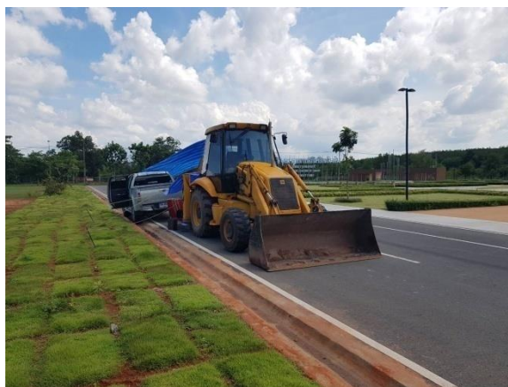
รูปที่ ซ.6 ทดสอบ Plate Bearing บนผิวทางแอสฟัลต์คอนกรีตผสมน้ำยางพารา 10%
