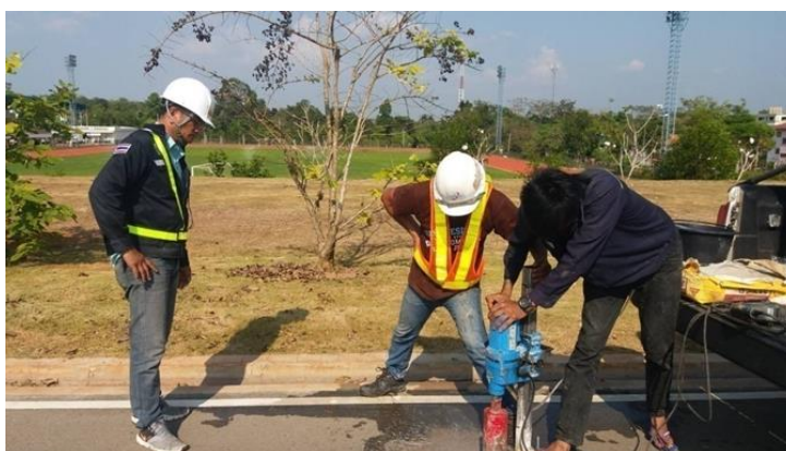
รูปที่ 3.17 การ Coring ผิวทาง
