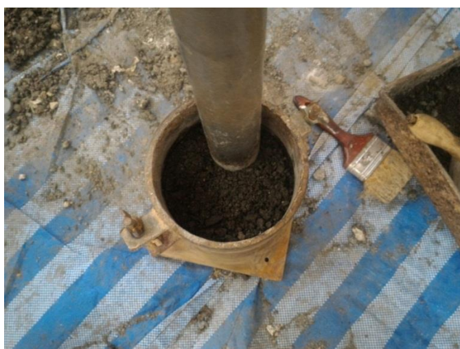
รูปที่ 3.6 การบดอัดดินในเบ้าด้วยค้อนบดอัด
