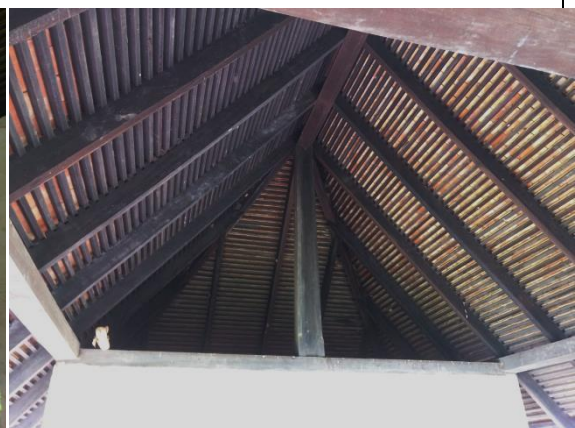
โครงสร้างหลังคาเป็นไม้ ใช้การเข้าไม้โดยการ เจาะใช้สลักเดือยซึ่งเป็นภูมิปัญญาช่างไทยในอดีต
