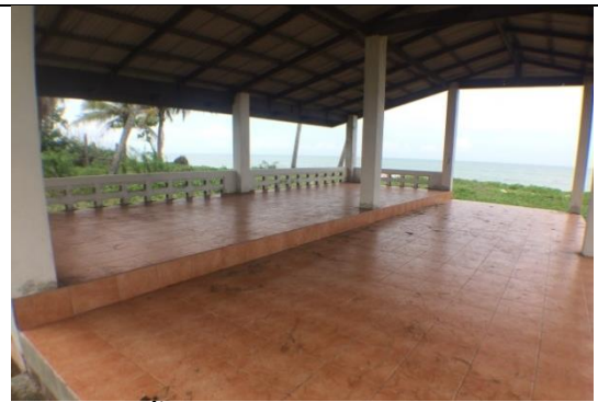
ลักษณะพื้นศาลาวัดท่าบอน ตำบลท่าบอน อำเภอระโนด 2 ชั้น เปลี่ยนแปลงจากพื้นไม้ เป็นพื้นคอนกรีตเสริมเหล็ก ปูกระเบื้องเซรามิก
