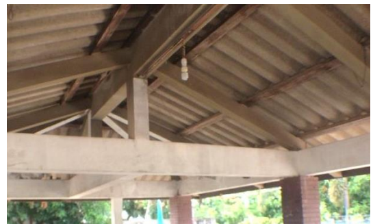
ลักษณะโครงสร้างหลังคาทรงจั่ว ศาลา เรือบ้านแหลมสน ตำบลหัวเขา อำเภอสิงหนคร เป็น คอนกรีตเสริมเหล็ก ทั้งคาน ออกไก่ จันทัน
