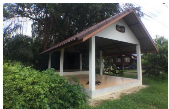
ศาลาครุฑ ตำบลรำแดง อำเภอสิงหนคร ได้รับการฟื้นฟูจากเสาไม้วางบนดินเสา (ต่อม่อ) ยกพื้นไม้ 2 ระดับ เป็นโครงสร้างคอนกรีตเสริมเหล็ก
