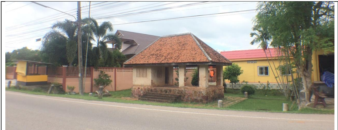
ศาลาหลบเสื่อ ตำบลหัวเขา อำเภอสิงหนคร หรือที่ชาวบ้านเรียกว่า “ศาลาจอม” ตั้งอยู่ริมถนน มีขอบเขตบริเวณชัดเจน มีบ้านพักอาศัยทั้งด้านข้างและด้านหลัง
