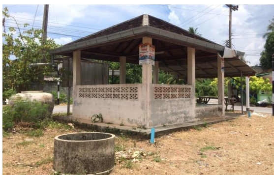
ศาลาบ่อสี่ก๊ก ตำบลท่าบอ อำเภอสิงหนคร ได้รับการฟื้นฟูจากเดิมเป็นเสาไม้วางบนดินเสา (ต่อม่อ) ยกพื้นไม้ 2 ระดับเป็นโครงสร้างคอนกรีตเสริมเหล็ก
