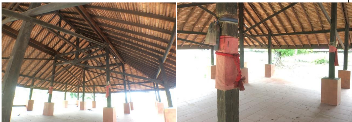
ลักษณะของศาลาทิดเปี้ยเป็นโครงสร้างไม้ โดยมีการใช้ไม้ตาลที่เป็นไม้ท้องถิ่นของคาบสมุทรมหานคร
