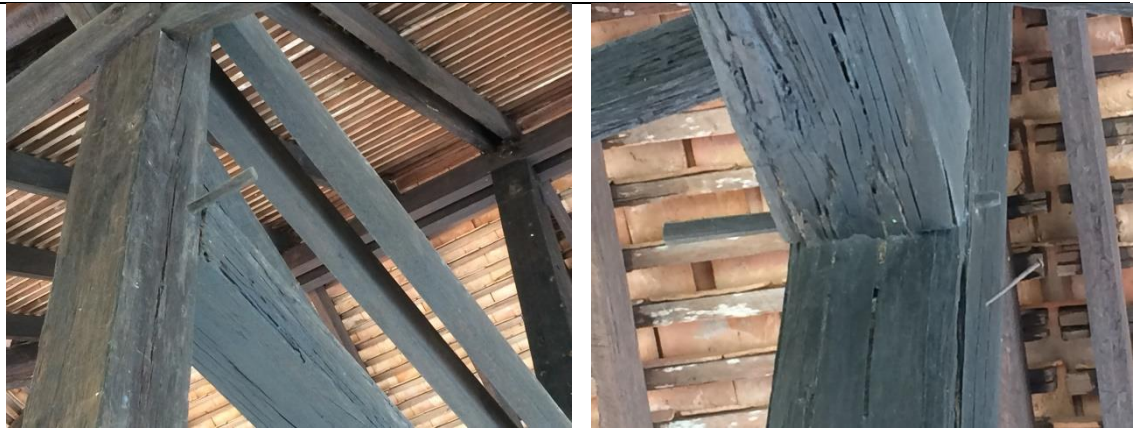
เทคนิคการก่อสร้างแบบโบราณที่ไม่ใช้ตะปู มีการเข้าไม้โดยการบาก เจาะ และใช้สลักเดือย ซึ่งแสดงถึงภูมิปัญญาเชิงช่างของผู้สร้าง
