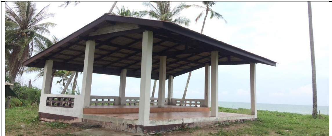
ศาลาวัดท่าบอน ตำบลท่าบอน อำเภอระโนด ได้รับการฟื้นฟูจากเดิมที่เป็นเสาไม้วางบนดินเสา (ต่อม่อ) ยกพื้นไม้ 2 ระดับ เป็นโครงสร้างคอนกรีตเสริมเหล็ก
