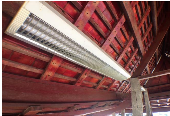
การฟื้นฟูศาลาในปี พ.ศ. 2561 ได้เพิ่มเติมระบบไฟฟ้าแสงสว่าง เพื่อให้เหมาะกับการใช้งานในปัจจุบัน
