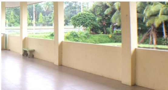
ลักษณะผนังกันตึกศาลาพังไทร ตำบลสนามไชย อำเภอสังขละบุรี เปลี่ยนแปลงจาก ราวไม้ในอดีตเป็นก่ออิฐฉาบปูนเรียบ ทาสี
