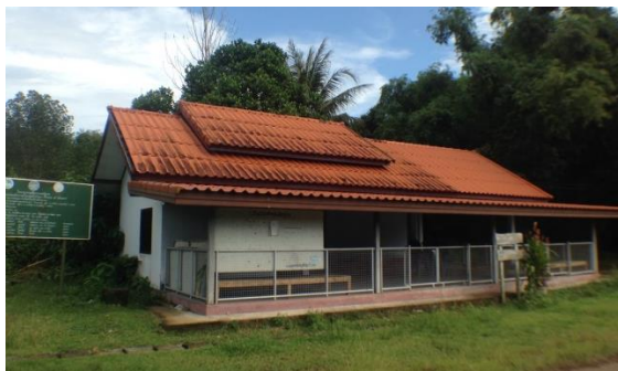
ศาลาเกษตรกร ตำบลเกาะใหญ่ อำเภอกระเสสินธุ์ สร้างขึ้นใหม่ทดแทนหลังเดิมเป็นโครงสร้างไม้ ขนาดเล็ก เป็นอาคารคอนกรีตเสริมเหล็ก
