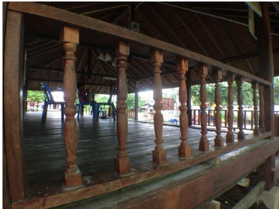
ลักษณะราวกันตกศาลาบ้านยางงาม ตำบลชิงโค อำเภอสิงหนคร เป็นไม้กลึง
