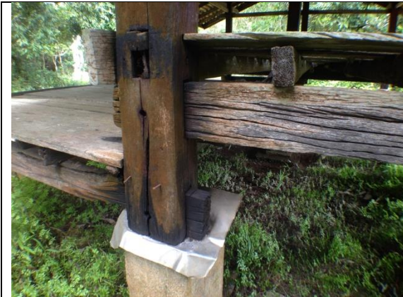
ลักษณะการเข้าไม้ เสาคาน ศาลาเปลวจิ้งจาย ตำบลชะแล้ อำเภอสิงหนคร ที่ไม้ใช้ตะปู
