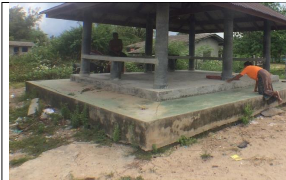
ลักษณะฐานศาลาพังช้างตาย ตำบลบ่อแดง อำเภอสังขละบุรี ที่ยกสูงแต่เป็นคอนกรีตเสริมเหล็ก พื้นระดับเดียว และทำที่นั่งแบบศาลารอรถ
