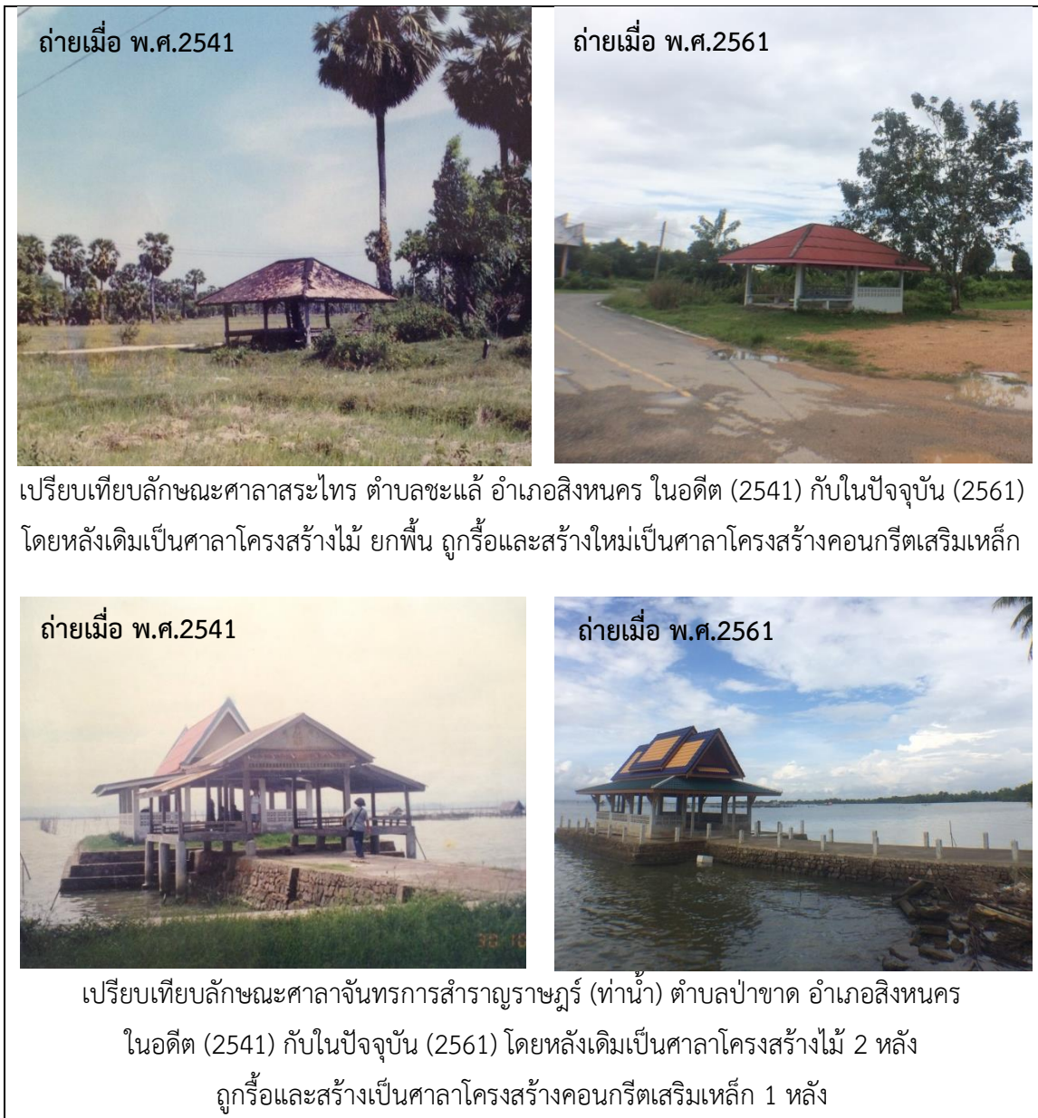
ภาพที่ 4. 23 ศาลากลางหนที่มีลักษณะเปลี่ยนแปลงไปจากเดิม
