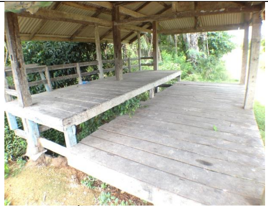
ลักษณะพื้นศาลาปากช่อง ตำบลชะแล้ อำเภอสิงหนคร เป็นพื้นไม้ ยก 2 ระดับ
