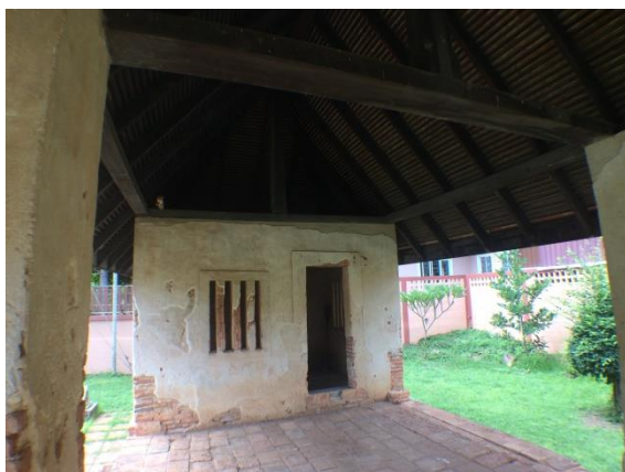
ภายในเป็นอาคารปล่อยโถงโล่งถึงใต้หลังคา ทำให้ถ่ายเทอากาศและความร้อนได้ดี
