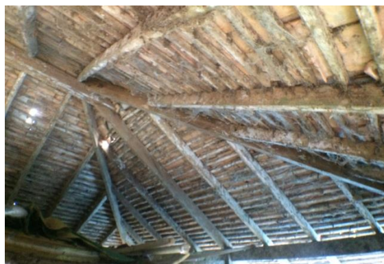
ลักษณะโครงสร้างหลังคาทรงปั้นหยา ศาลาชายเหมือง ตำบลชะแล้ อำเภอสิงหนคร ใช้ไม้ตาล ซึ่งเป็นไม้ในท้องถิ่น
