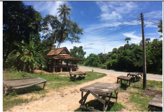
บริเวณด้านหลังศาลาเก้าบ่อเป็นที่โล่งกว้าง ใช้เป็นตลาดนัดประจำชุมชน แต่ภายในศาลา ไม่ได้ใช้เป็นพื้นที่ขายของ
