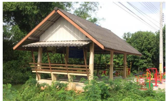
ศาลาบ้านคลองฉนวน ตำบลชุมพล อำเภอ สทิงพระ ได้รับการฟื้นฟูจากเสาไม้วางบนดินเสา ยกพื้นไม้ เป็นโครงสร้างคอนกรีตเสริมเหล็ก
