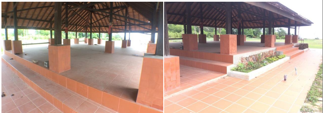
ศาลาทิดเปี้ยได้ถูกฟื้นฟูในปี พ.ศ. 2560 มีการปรับพื้นโดยรอบ เป็นพื้นคอนกรีตเสริมเหล็ก เพิ่มบันไดขึ้นบนศาลาทั้ง 4 ด้าน ปูพื้นศาลาด้วยกระเบื้องดินเผาทั้งภายในและภายนอกของอาคาร
