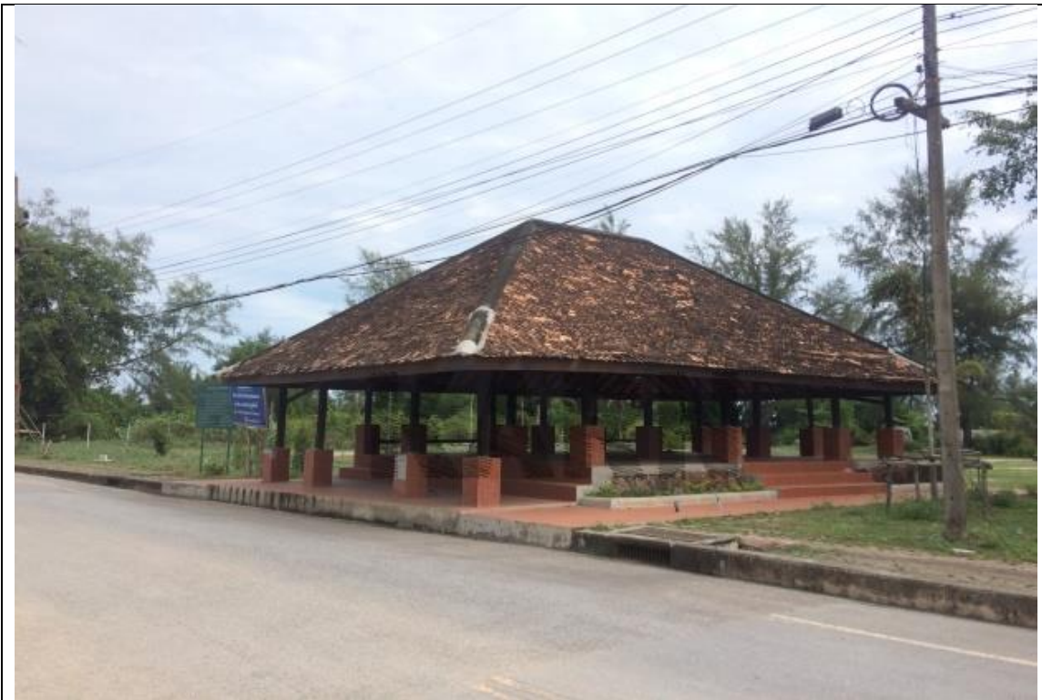
ศาลาทิดเปี้ย ตำบลชิงโค อำเภอสิงหนคร เป็นศาลาพื้นคอนกรีตขนาดใหญ่อยู่ริมทะเลฝั่งอ่าวไทย ได้รับการซ่อมแซมเมื่อ พ.ศ.2561 ในลักษณะรูปแบบเดิม
