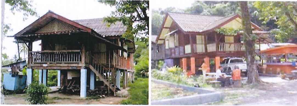
ภาพที่ 33 บ้านพักนายสถานีรถไฟกันตังก่อนและหลังการปรับปรุง ที่มา : ตรังโซน, 2553 และถ่ายโดยผู้วิจัยเมื่อวันที่ 10 ธันวาคม 2557
