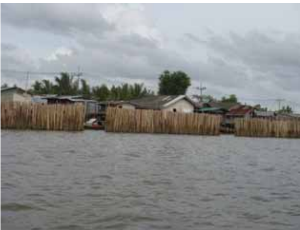
รูปที่ 4-4 กำแพงไม้ไผ่เพื่อชะลอแรงคลื่นและบรรเทาการกัดเซาะชายฝั่งตามแนวชายฝั่งคลอง หมู่ที่ 1 บ้านเกาะกลาง
