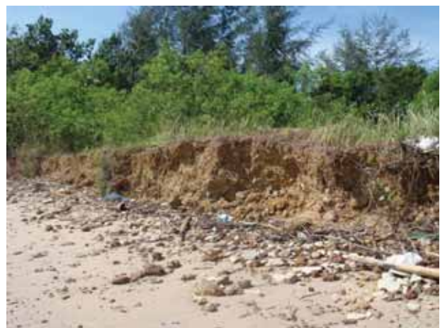
รูปที่ 4-5 การกัดเซาะชายหาดด้านที่ติดทะเล หมู่ที่ 2 บ้านคลองประสงค์
