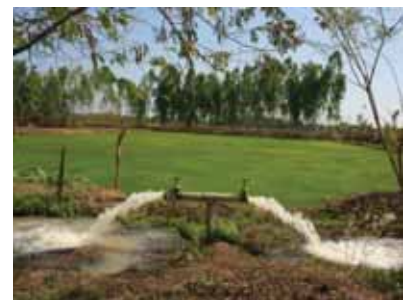
รูปที่ 3-46 สถานีสูบน้ำด้วยพลังงานไฟฟ้าและระบบส่งน้ำด้วยท่อแรงดันสูง
