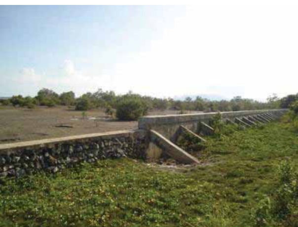
รูปที่ 4-6 กำแพงคอนกรีตเสริมเหล็กป้องกันการกัดเซาะชายหาดด้านที่ติดทะเล หมู่ที่ 2 บ้านคลองประสงค์
