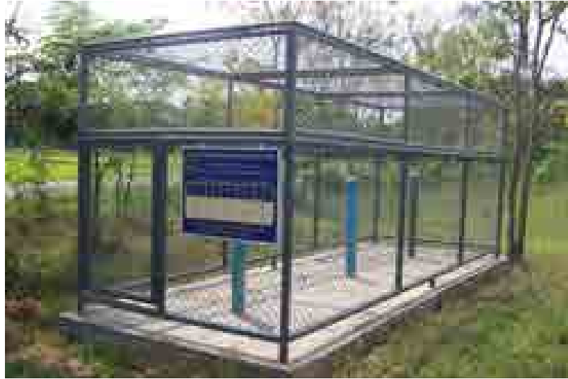
รูปที่ 2.1 สถานีสังเกตการณ์น้ำบาดาล
