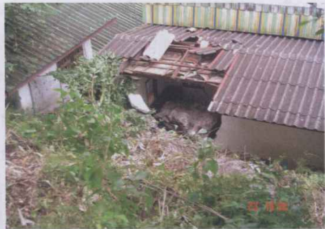
รูปที่ 2.5 ก้อนหินปูนขนาดใหญ่ร่วงหล่นจากหน้าผา ที่บ้านเลขที่ 151 ถนนถ้ำนาคำ อำเภอเมือง
