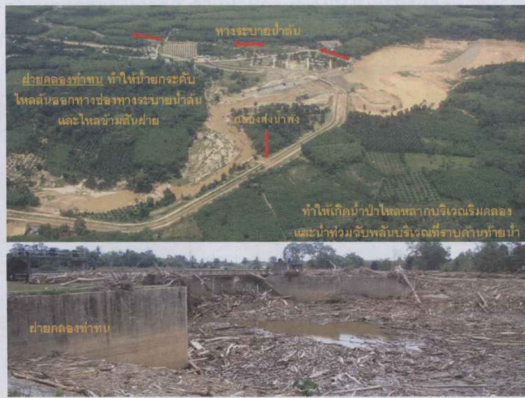
รูปที่ 5.2 ฝายคลองท่าทบที่สร้างกีดขวางทางน้ำ
