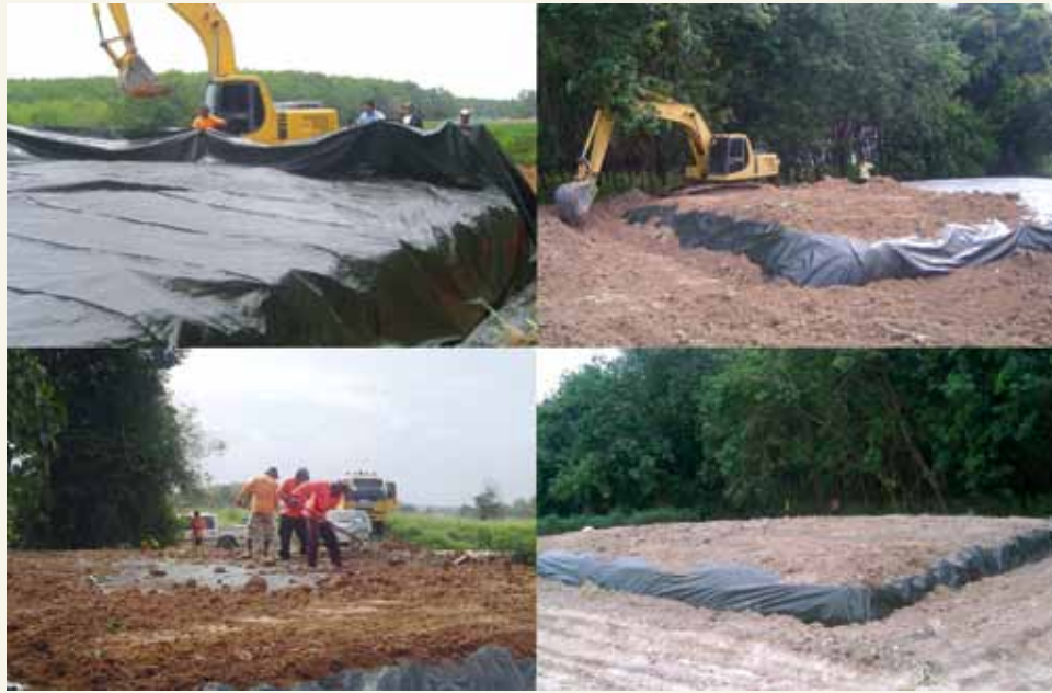
รูปที่ 77 การดำเนินการปิดคลุม (Capping) พื้นที่ที่มีการลักลอบทิ้งฯ เมื่อวันที่ 22 - 25 พฤษภาคม 2551
