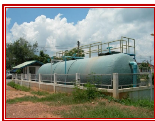
รูปที่ 18 ระบบบำบัดน้ำเสียแบบรวมกลุ่มอาคาร
