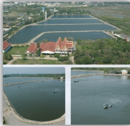
ระบบสระเติมอากาศ (Aerated Lagoon : AL)
