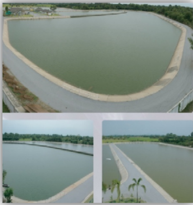
ระบบบ่อปรับเสถียร (Stabilization Pond : SP)
