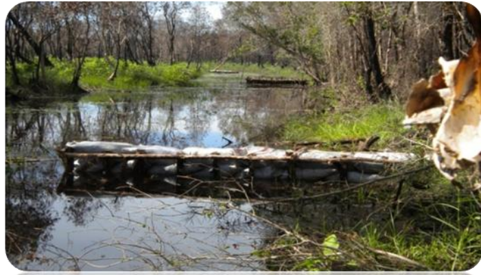
การสร้างฝายชะลอน้ำ เพื่อเก็บกักน้ำในดินให้ชุ่มชื้นและลดความเร็วของกระแส น้ำที่กัดเซาะหน้าดินและตลิ่ง
