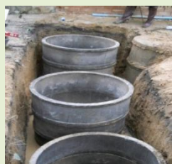
การก่อสร้างระบบอดกรองไร้อากาศ
