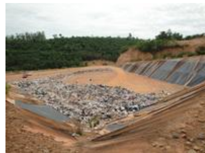
ระบบกำจัดขยะมูลฝอยแบบถูกหลักสุขาภิบาล เทศบาลเมืองบ้านพรุ
