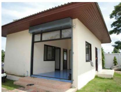
อาคารควบคุมระบบ
