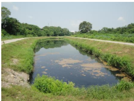
บ่อดกตะกอน
