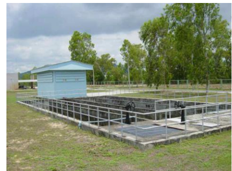
คลองวนเวียนและอาคารเติมคลอรีน
