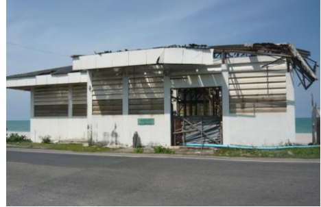
สถานีสูบน้ำเสียที่ 4 (PS4)
