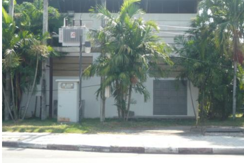
สถานีสูบน้ำเสียที่ 2 (PS2)
