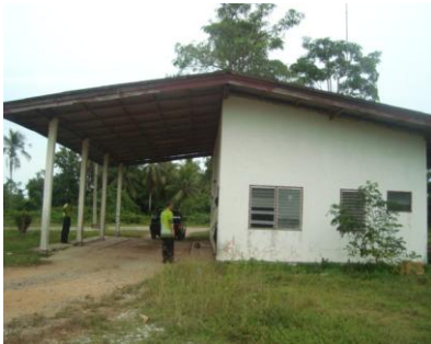
อาคารชั่งน้ำหนักขยะ
