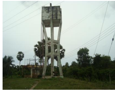
ระบบประปา
