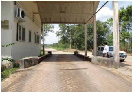
อาคารชั่งน้ำหนัก
