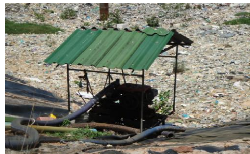
เครื่องสูบน้ำชะขยะจากหลุมฝังกลบ
