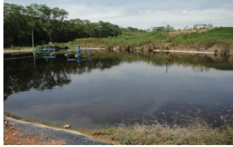
บำบัดน้ำเสียแบบไร้อากาศ (บ่อหมัก)
