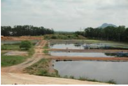
ระบบบำบัดน้ำชะขยะมูลฝอย
