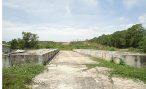
บำบัดน้ำเสียแบบใช้อากาศ (บ่อบ่ม)
