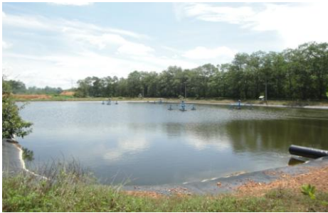
บำบัดน้ำเสียแบบกึ่งไร้อากาศ (บ่อผึ่ง)
