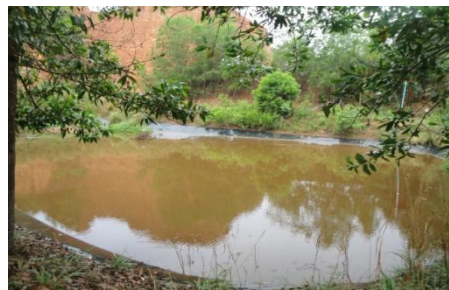
บ่อบำบัดน้ำเสียแบบใช้อากาศ (บ่อป่ม)
