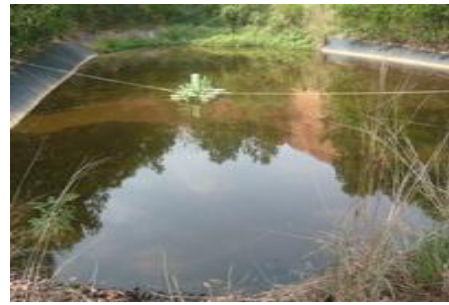
บ่อบำบัดน้ำเสียแบบไร้อากาศ (บ่อหมัก)
