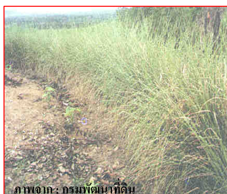
ภาพที่ 16 คันดินกั้นน้ำแบบลดระดับเพื่อระบายน้ำออกจากพื้นที่ มีการปลูกหญ้าแฝกบนคันดินเพื่อเสริมความมั่นคงของคันดิน
