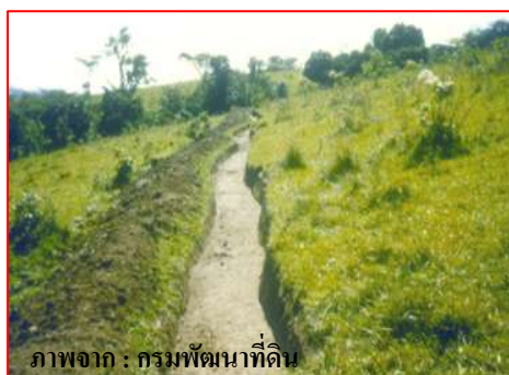
ภาพที่ 17 คูรับน้ำขอบเขาหรือรอบเขาที่มีลักษณะเป็นร่องน้ำ
