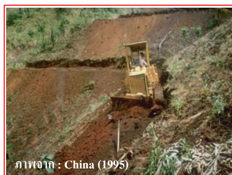
ภาพที่ 18 คูรับน้ำแบบกว้าง ลักษณะคล้ายขั้นบันไดแบบฐานกว้าง
