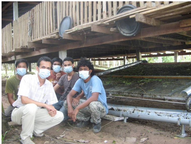
ภาพที่ 5 การติดตั้งเครื่องกวาดเก็บมูลแพะในฟาร์มเกษตรกร
