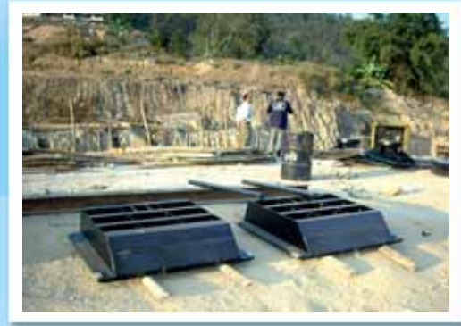
การติดตั้งบานระบายรับน้ำแรงดันสูง (HIGH PRESSURE SLIDE GATE) ณ โครงการอ่างเก็บน้ำดอยงู จังหวัดเชียงราย
