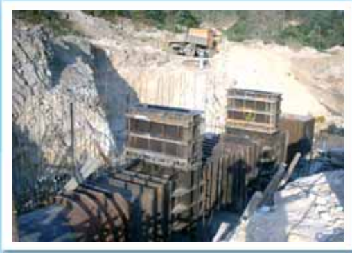
การติดตั้งบานระบายรับน้ำแรงดันสูง (HIGH PRESSURE SLIDE GATE) ณ โครงการอ่างเก็บน้ำดอยงู จังหวัดเชียงราย
