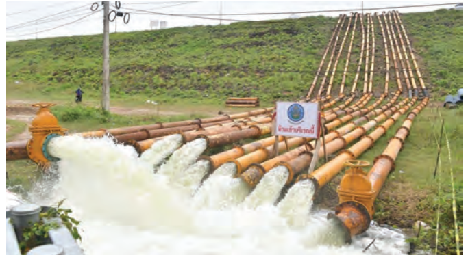
➤ ติดตั้งเครื่องสูบน้ำในพื้นที่ประสบอุทกภัย
