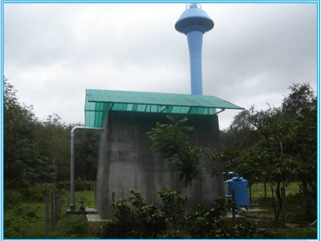
โครงการจัดหาน้ำอุปโภค-บริโภคช่วยเหลือราษฎรหมู่ที่ 1 และ 2 ต.ฉลุง
