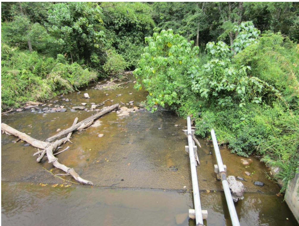
สภาพบริเวณแนวท่อส่งน้ำ และอาคารสลายพลังงานท้ายฝาย โครงการปรับปรุงระบบส่งน้ำโรงเรียนตำรวจตระเวนชายแดนสีมวชนกกีฬา อันเนื่องมาจากพระราชดำริ ตำบลสำนักแต้ว อำเภอสะเตา จังหวัดสงขลา
