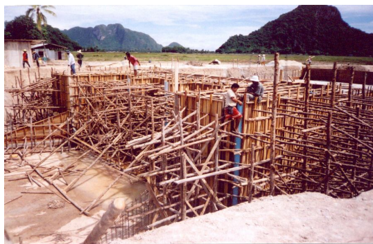
ระหว่างก่อสร้างท่อระบายน้ำบ้านปลายทอง
