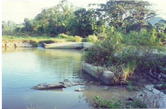
ก่อนก่อสร้างท่อระบายน้ำบ้านปลายทอง
