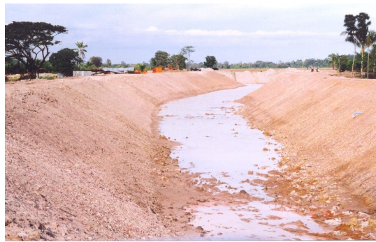
ระหว่างขุดลอกคลองและก่อสร้างคันกั้นน้ำสองฝั่งคลอง
