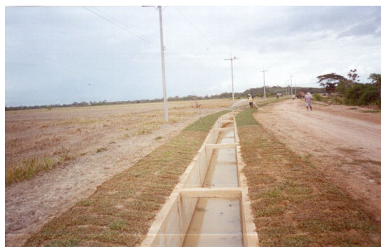
หลังก่อสร้างรางส่งน้ำสายใหญ่ฝั่งขวา 2
