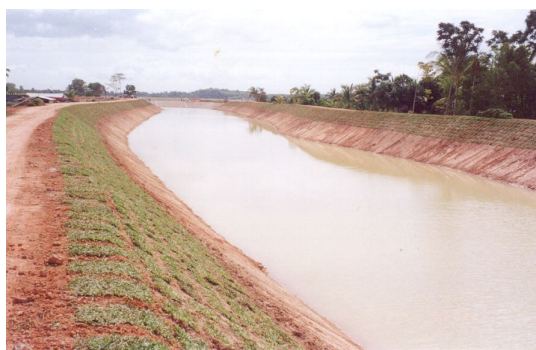
หลังขุดลอกคลองและก่อสร้างคันกั้นน้ำสองฝั่งคลอง
