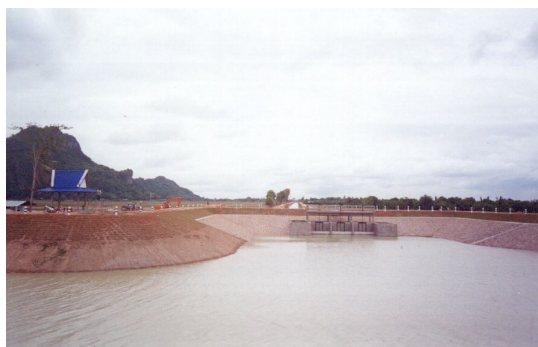
หลังก่อสร้างท่อระบายน้ำบ้านปลายทอง
