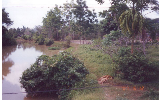
ก่อนขุดลอกคลองและก่อสร้างคันกั้นน้ำสองฝั่งคลอง
