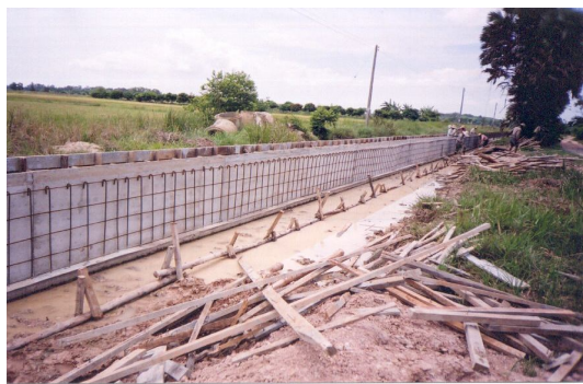
ระหว่างก่อสร้างรางส่งน้ำสายใหญ่ฝั่งขวา 2
