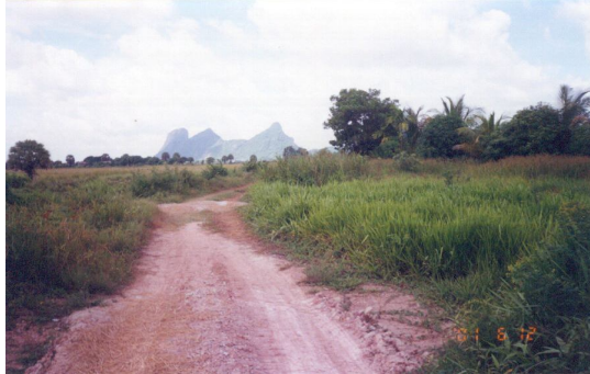
ก่อนก่อสร้างรางส่งน้ำสายใหญ่ฝั่งขวา 2
