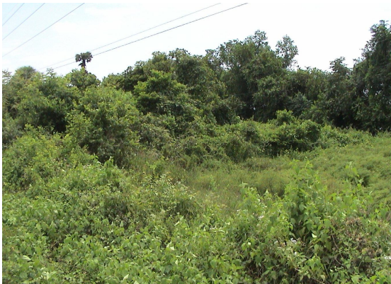
จุดก่อสร้างสถานีสูบน้ำ
