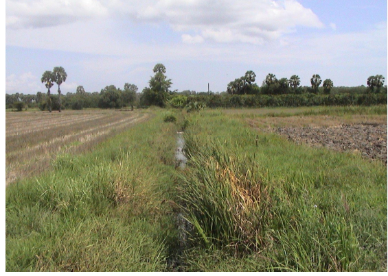
แนวก่อสร้างระบบส่งน้ำ
