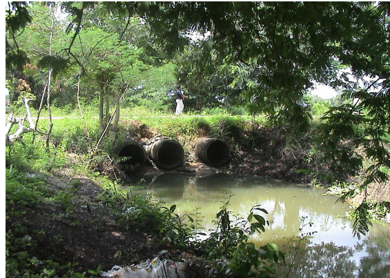
จุดที่แนวก่อสร้างระบบส่งน้ำตัดกับถนน
