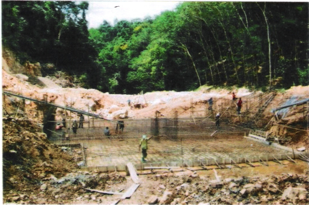
กำลังดำเนินการก่อสร้าง
