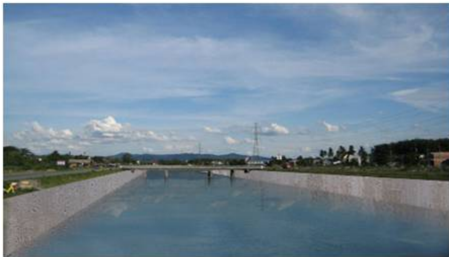
รูปที่ 17. คลองระบายน้ำ ร.1 หลังจากปรับปรุง
