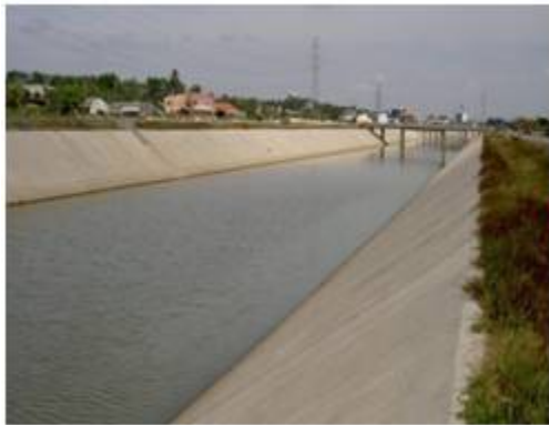
รูปที่ 15. แบบคลองระบายน้ำ ช่วง กม.0+000 ถึง กม.14+460 (ปรับปรุงจากคลองดินเป็นคลองคอนกรีตเสริมกำแพงตั้ง)
