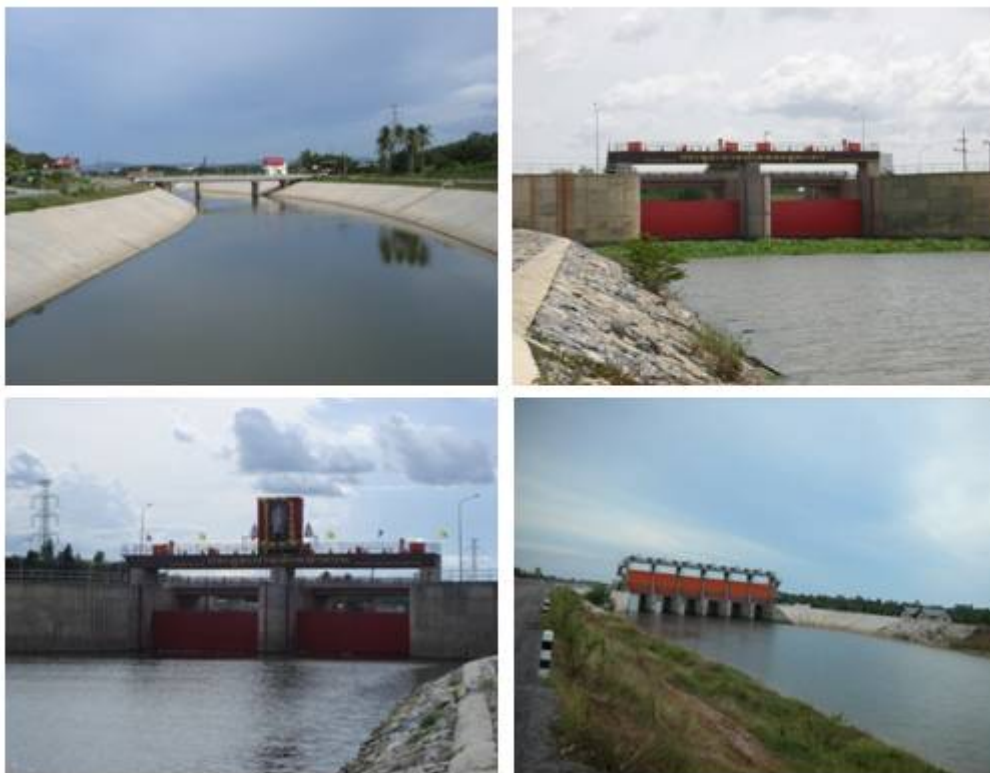
รูปที่ 4. คลองระบายน้ำ ร.1 พร้อมอาคารประกอบ
