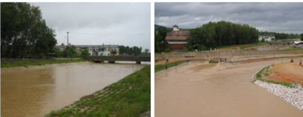
รูปที่ 7. คลองระบายน้ำ ร.5 พร้อมอาคารประกอบ
