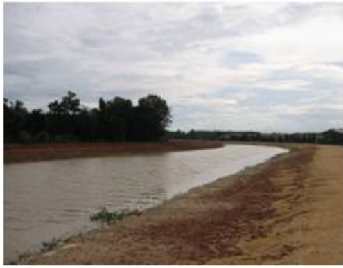
รูปที่ 15. แบบคลองระบายน้ำ ช่วง กม.0+000 ถึง กม.14+460 (ปรับปรุงจากคลองดินเป็นคลองคอนกรีตเสริมกำแพงตั้ง)
