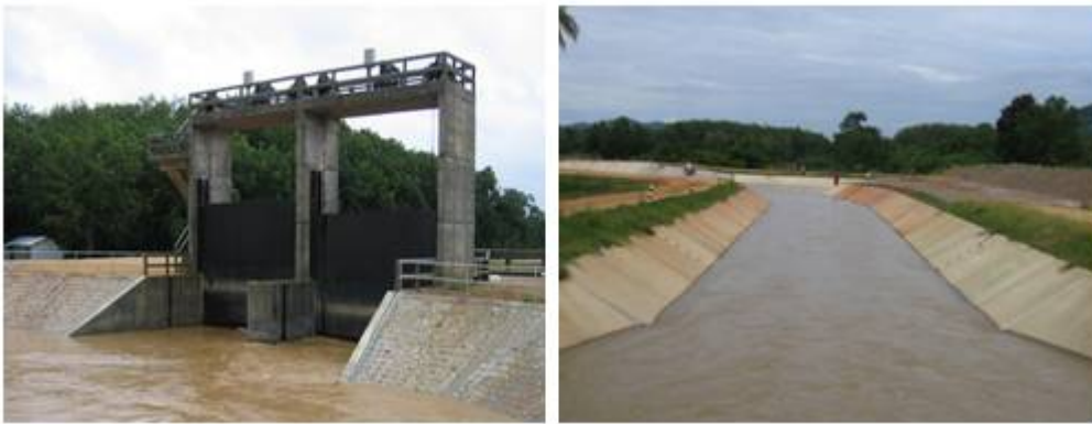
รูปที่ 6. คลองระบายน้ำ ร.4 พร้อมอาคารประกอบ
