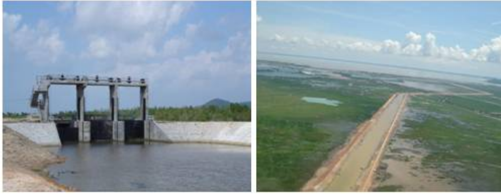
รูปที่ 5. คลองระบายน้ำ ร.3 พร้อมอาคารประกอบ
