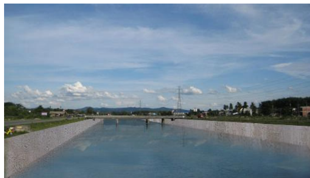
รูปที่ 4. คลองระบายน้ำ ร.1 หลังจากปรับปรุง
