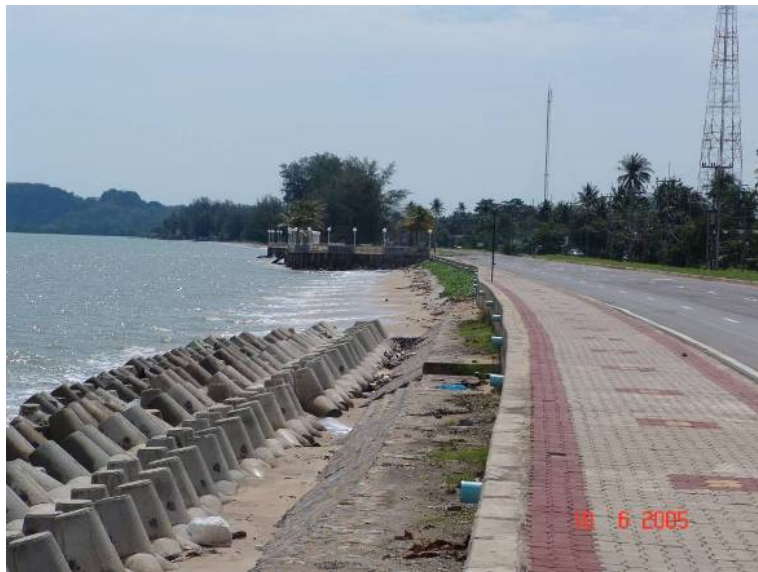
รูปที่ 3 กำแพงกันคลื่นซึ่งจัดเรียงด้วยแท่งคอนกรีต
