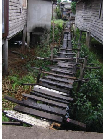
รูป 2.6 สะพานไม้เคี่ยมภายในชุมชนบ้านทะเลน้อย
