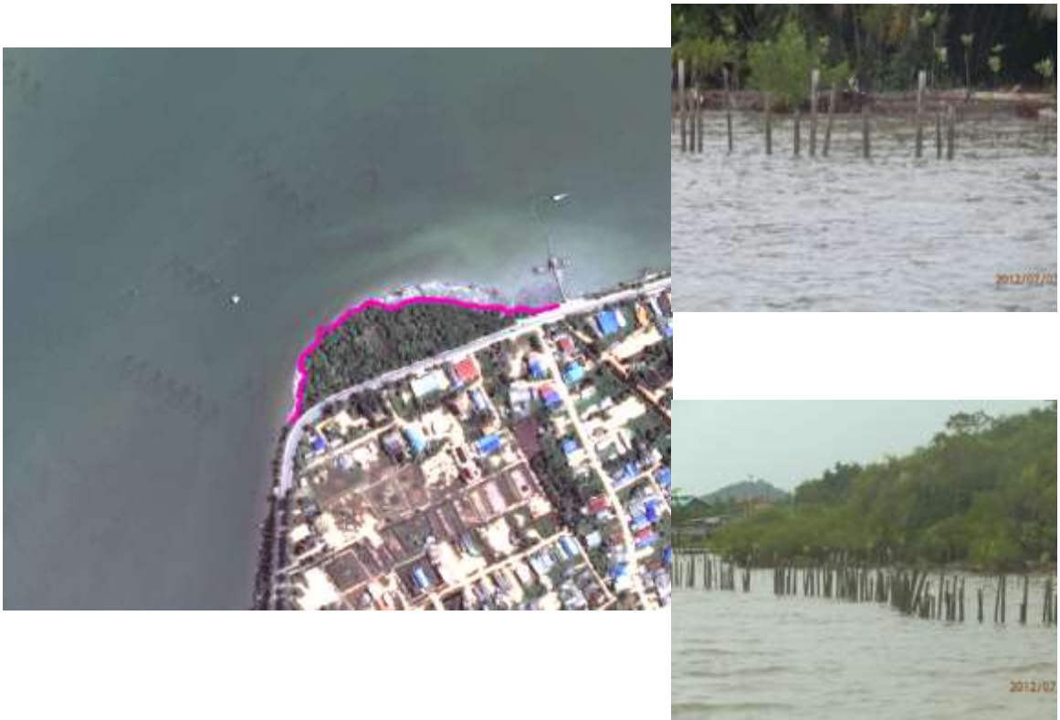
รูปที่ ๒-๕๒ ภาพถ่ายทางอากาศและภาพถ่ายแสดงสภาพการกัดเซาะชายฝั่ง บริเวณบ้านท่าสะอ้าน ต.พะวง อ.เมือง จ.สงขลา ที่มาข้อมูล: พยอม รัตนมณี, ๒๕๕๕ (จากการติดต่อส่วนตัว)
