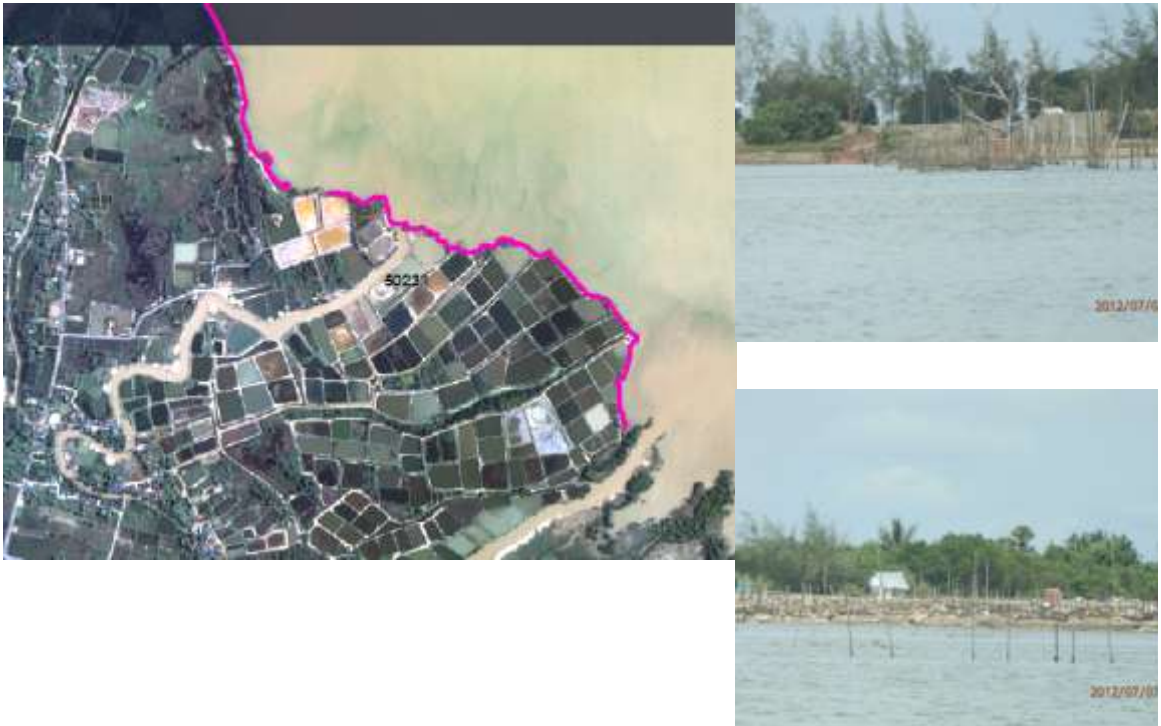
รูปที่ ๒-๔๘ ภาพถ่ายทางอากาศและภาพถ่ายแสดงสภาพการกัดเซาะชายฝั่ง บริเวณบ้านใต้ ต.คูเต่า อ.หาดใหญ่ จ.สงขลา ที่มาข้อมูล: พยอม รัตนมณี, ๒๕๕๕ (จากการติดต่อส่วนตัว)
