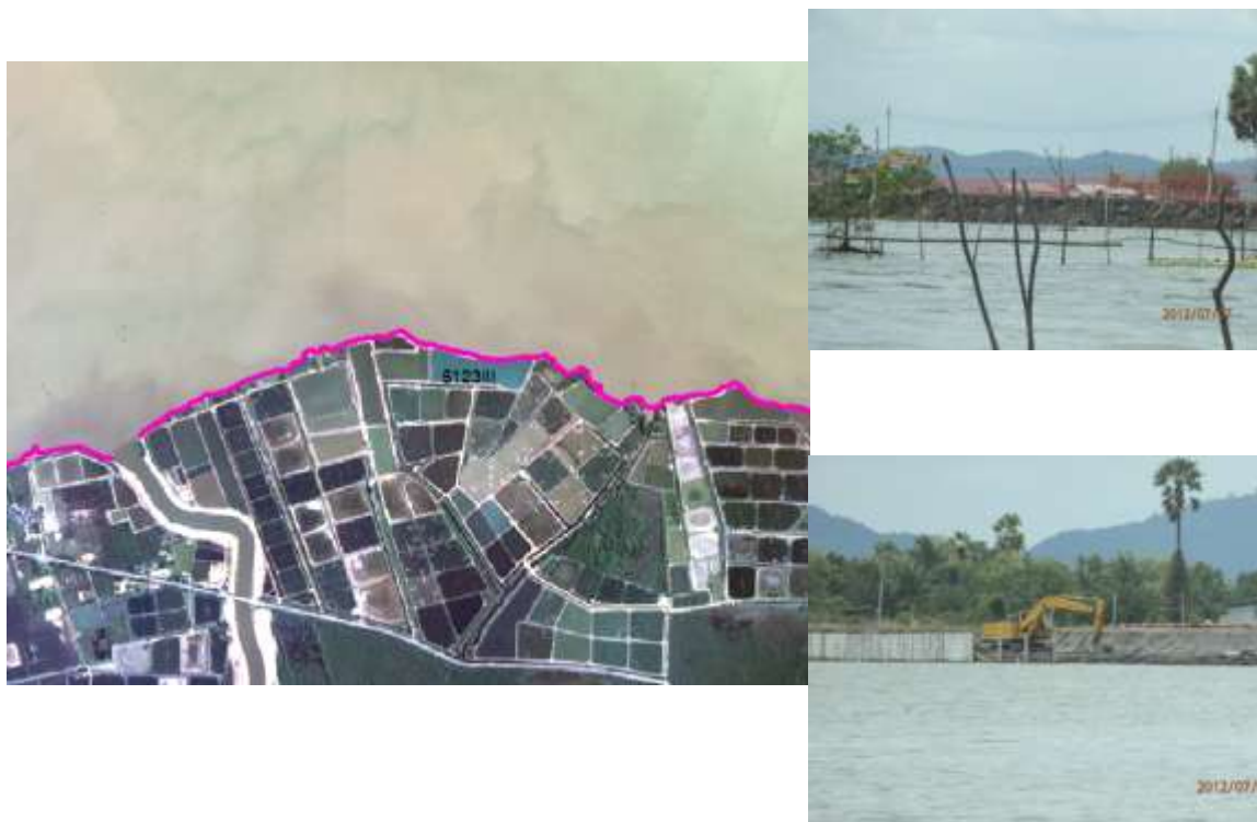
รูปที่ ๒-๕๐ ภาพถ่ายทางอากาศและภาพถ่ายแสดงสภาพการกัดเซาะชายฝั่ง บริเวณบ้านท่านางหอม ต.น้ำน้อย อ.หาดใหญ่ จ.สงขลา ที่มาข้อมูล: พยอม รัตนมณี, ๒๕๕๕ (จากการติดต่อส่วนตัว)
