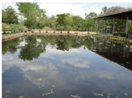
บ่อบำบัดน้ำเสียแบบไร้อากาศ (บ่อหมัก)
