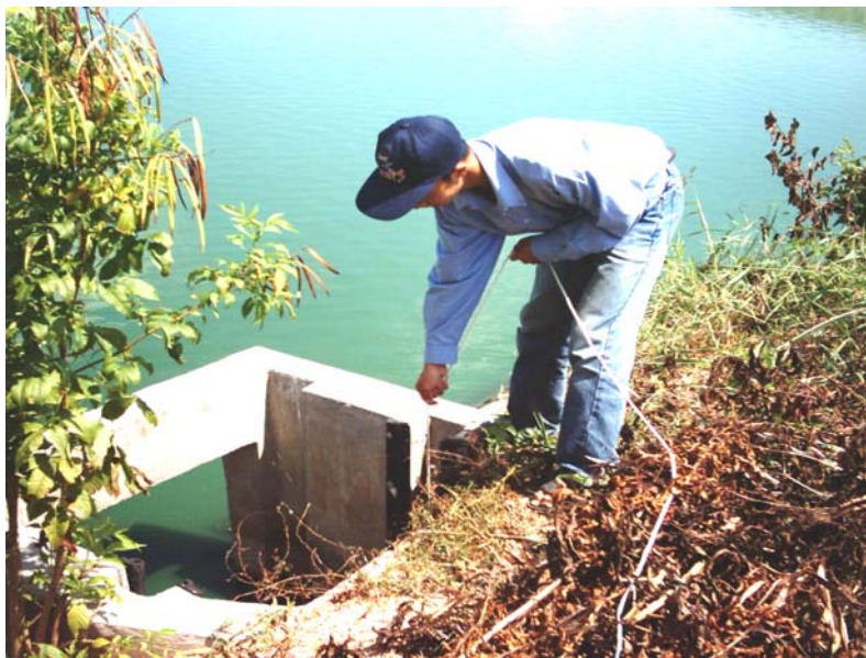
ภาพประกอบภาคผนวก จ 7 จุดน้ำทิ้งออกจากบ่อบำบัดร่วมกับพืชลอยน้ำ ๑ หาดใหญ่ (ปล่อยน้ำทิ้งเข้าสู่บ่อพักน้ำ)
