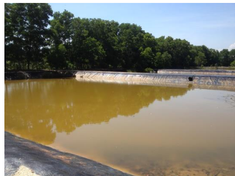
รูปที่ 4.5-5 ระบบบำบัดน้ำชะขยะมูลฝอย
