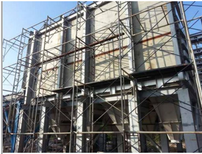
โครงสร้างเตายังไม่เสร็จดี
